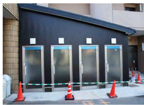
建設中の発熱者専用待合室
